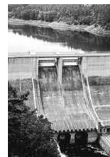
Obr. 14 Malá vodní elektrárna
