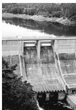
Obr. 14 Malá vodní elektrárna
